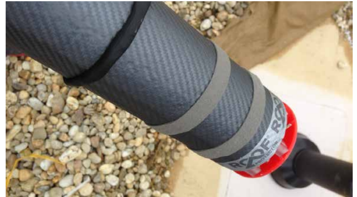
SCHRITT 11 – ABDICHTUNG MITTELS KOMBRIBAND UND BUTYL RUNDDICHTSCHNUR
