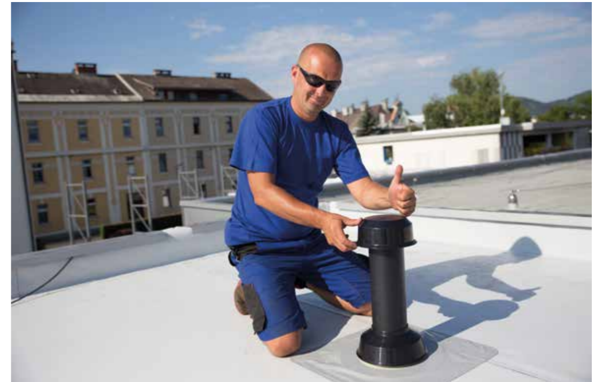
SCHRITT 18 – ENDKONTROLLE UND BAUSTELLE BERÄUMEN
