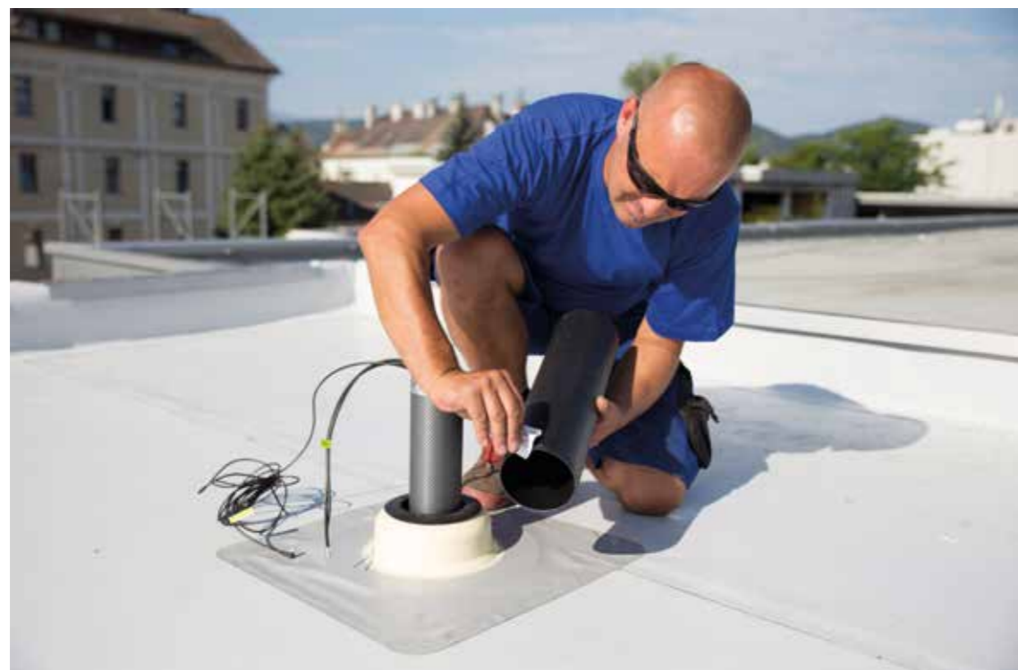
SCHRITT 9 – ROHR AN ANSCHLUSSFLANSCH MONTIEREN
