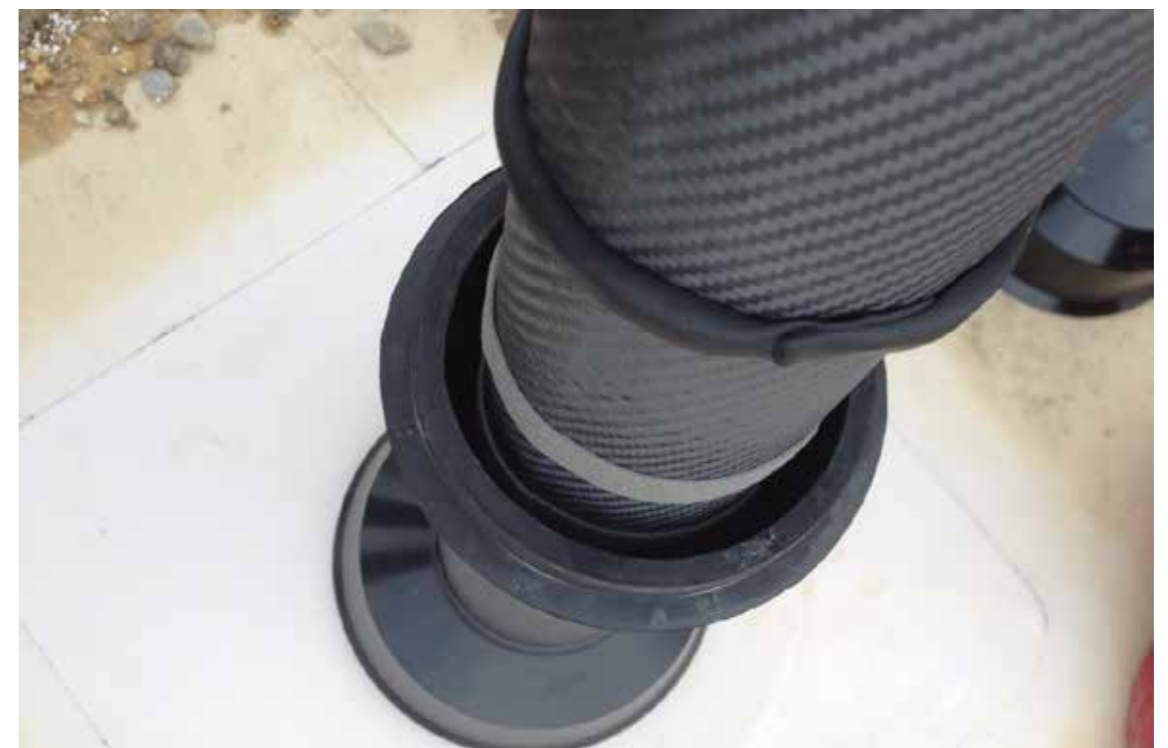
SCHRITT 12 – ROOF PROTECTORS EINSETZEN
