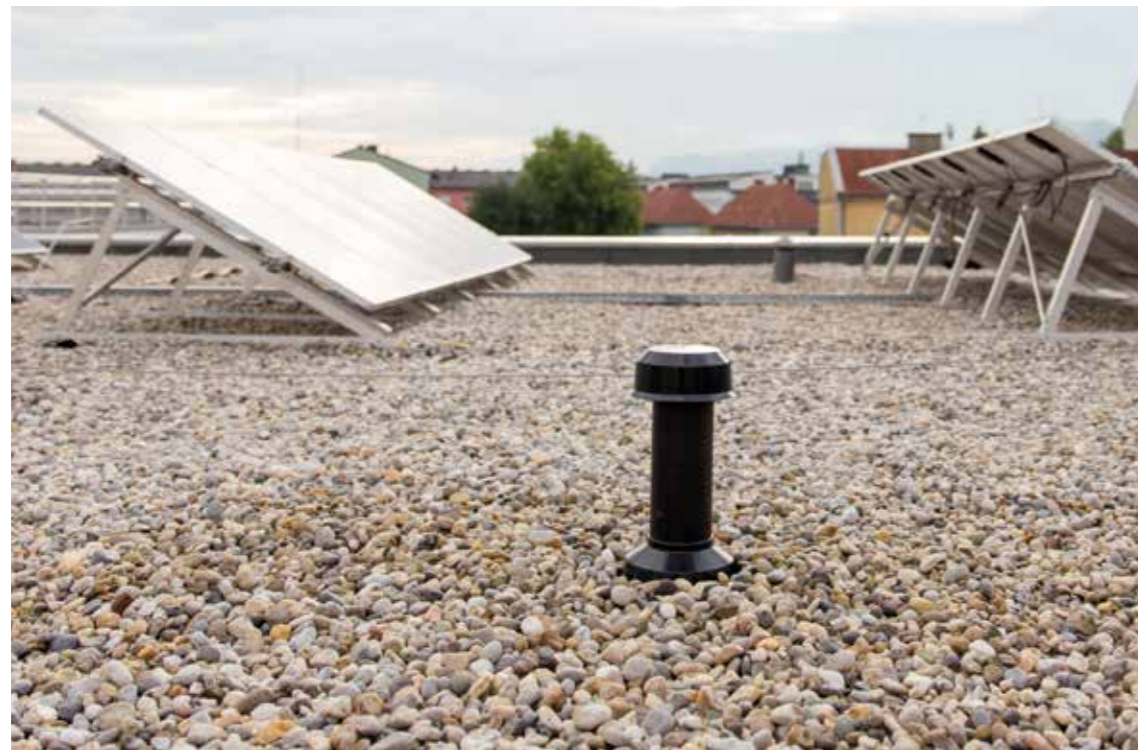
SCHRITT 17 – EINBAUORT MIT KIES VERSCHLIESSEN (NUR BEI BEKIESTEN DACH)
