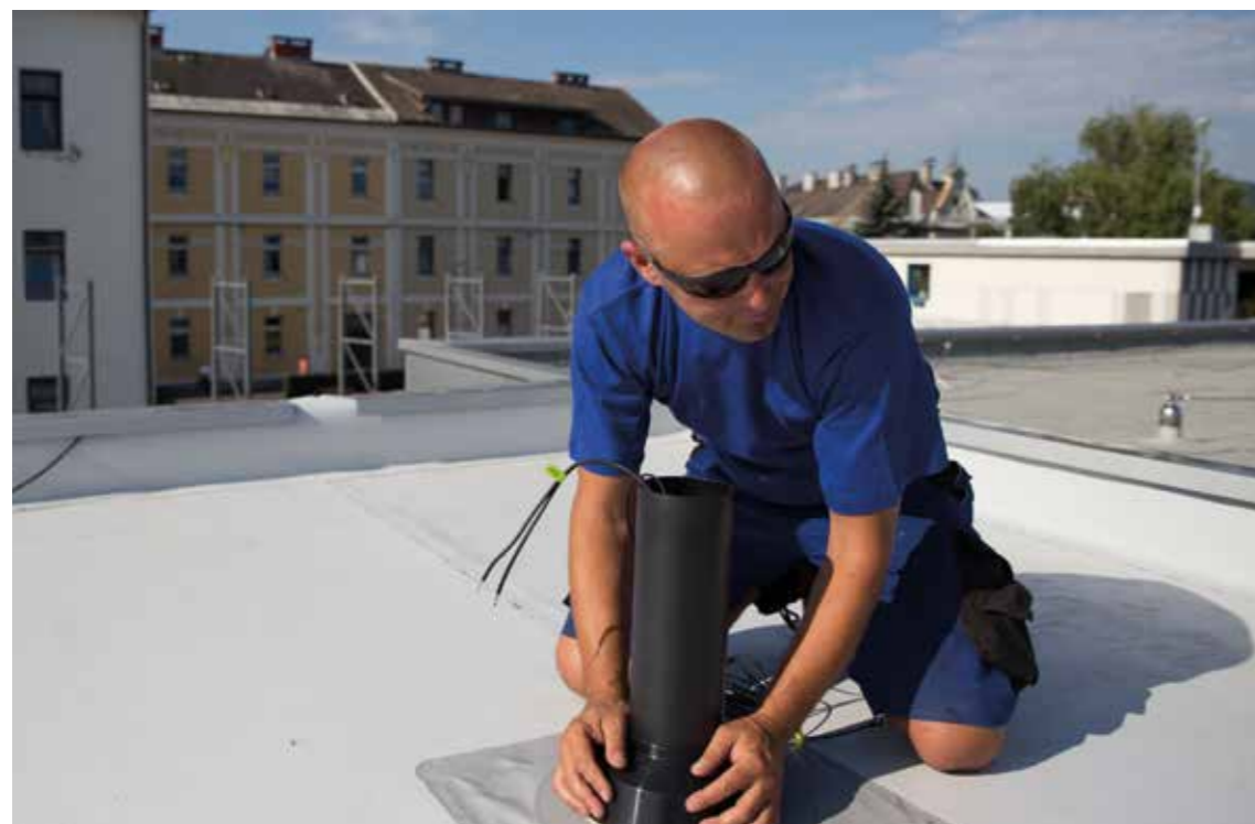
SCHRITT 10 – ROHR AN ANSCHLUSSFLANSCH MONTIEREN
